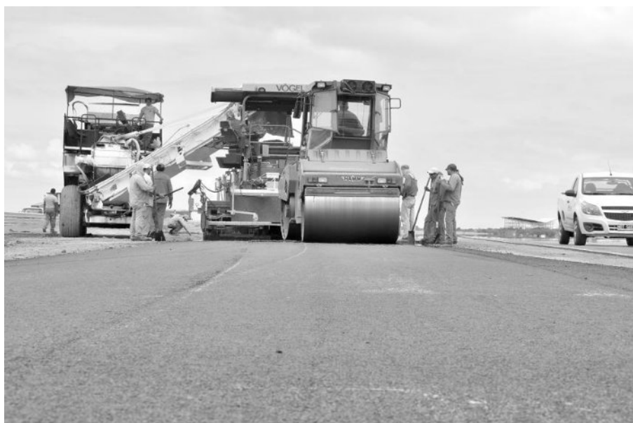
Figura 7: Equipo de compactación oscilatoria trabajando
