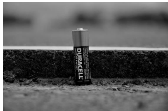
Figura 2: Espesor de la capa de rodadura tipo SMA 10
